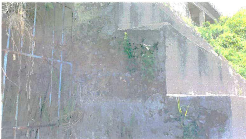
Figura 14 – Parede do acesso da galeria apresentando CCR sem proteção (20/04/16).
