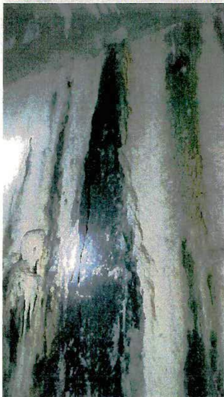
Figura 11 – Material carreado por infiltração na parede de montante da galeria (20/04/16).
