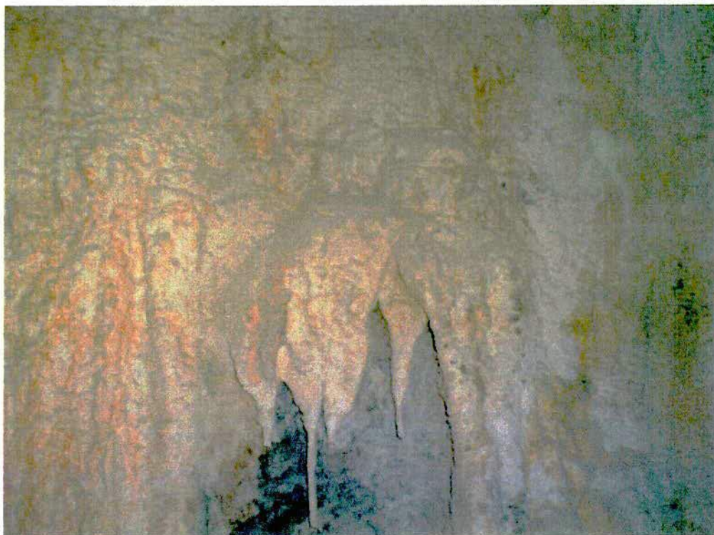
Figura 8 – Formação de estalactites por material carreado pelas infiltrações no teto da galeria (20/04/16).
