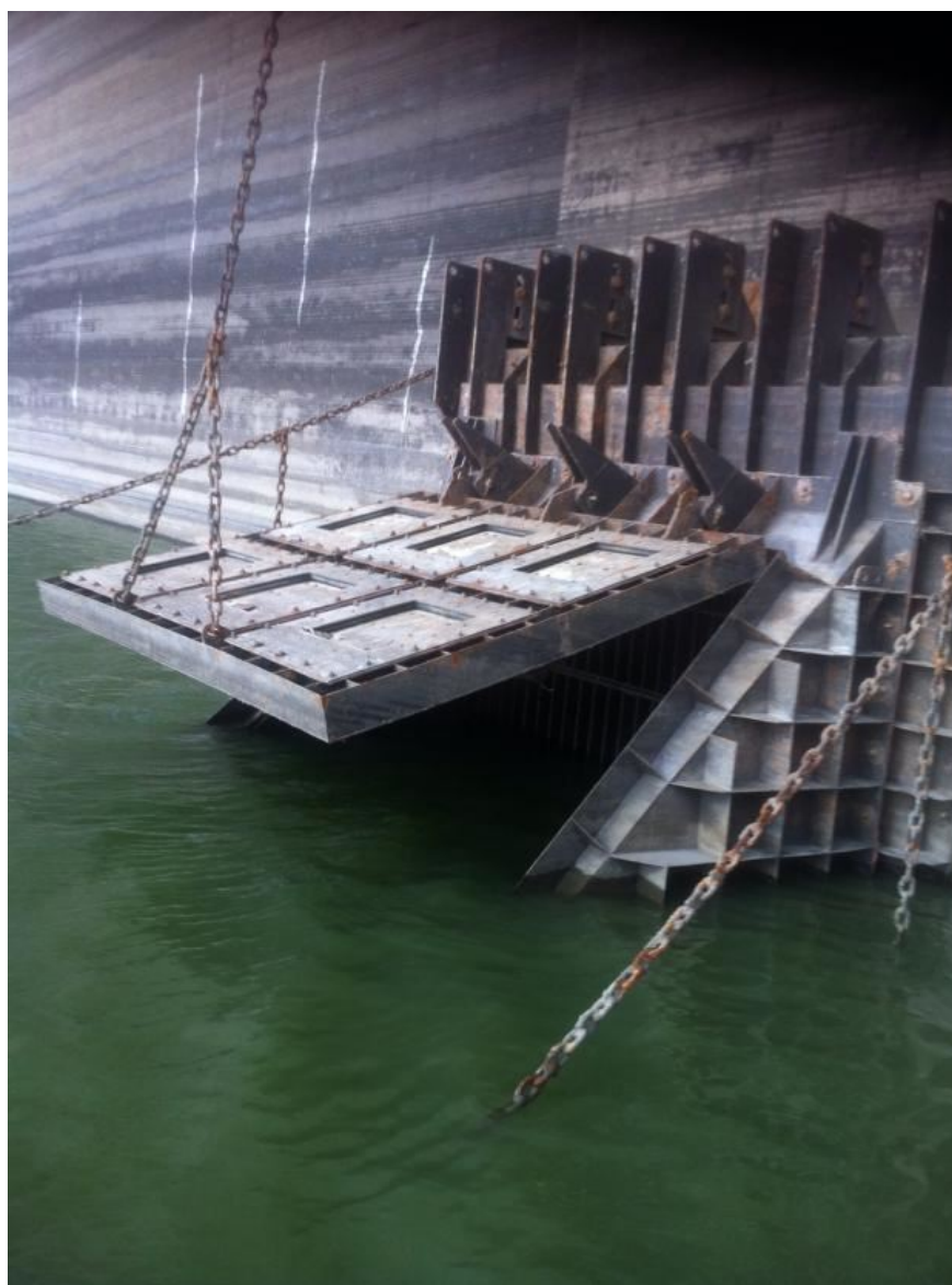
Figura 9 – Visão detalhada da tomada d'água do açude Jucazinho
