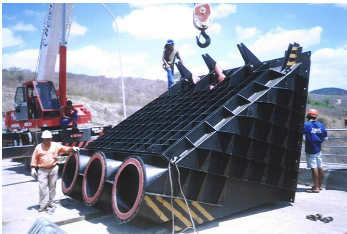
Figura 5 – Estrutura da tomada d'água do açude Jucazinho com os 3 orifícios que recebem a água captada do flutuante
