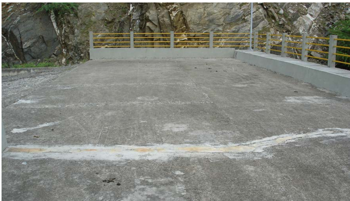
Detalhe de fissura na laje do coroamento próximo à ombreira direita
