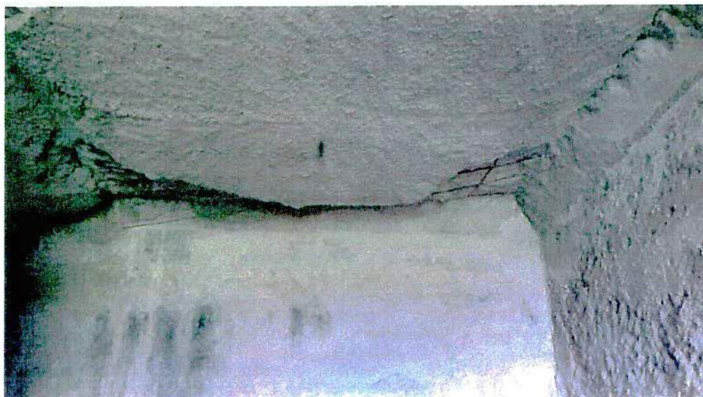
Figura 4 – Laje de teto sugerindo descolagem e desabamento com exposição da ferragem (20/04/16).
