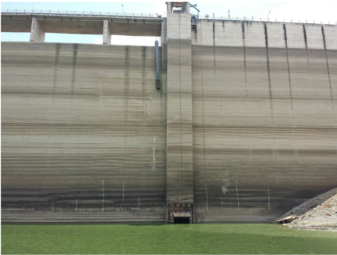
Figura 6 – Vista da tomada d'água e da captação pelo sifão no açude Jucazinho
