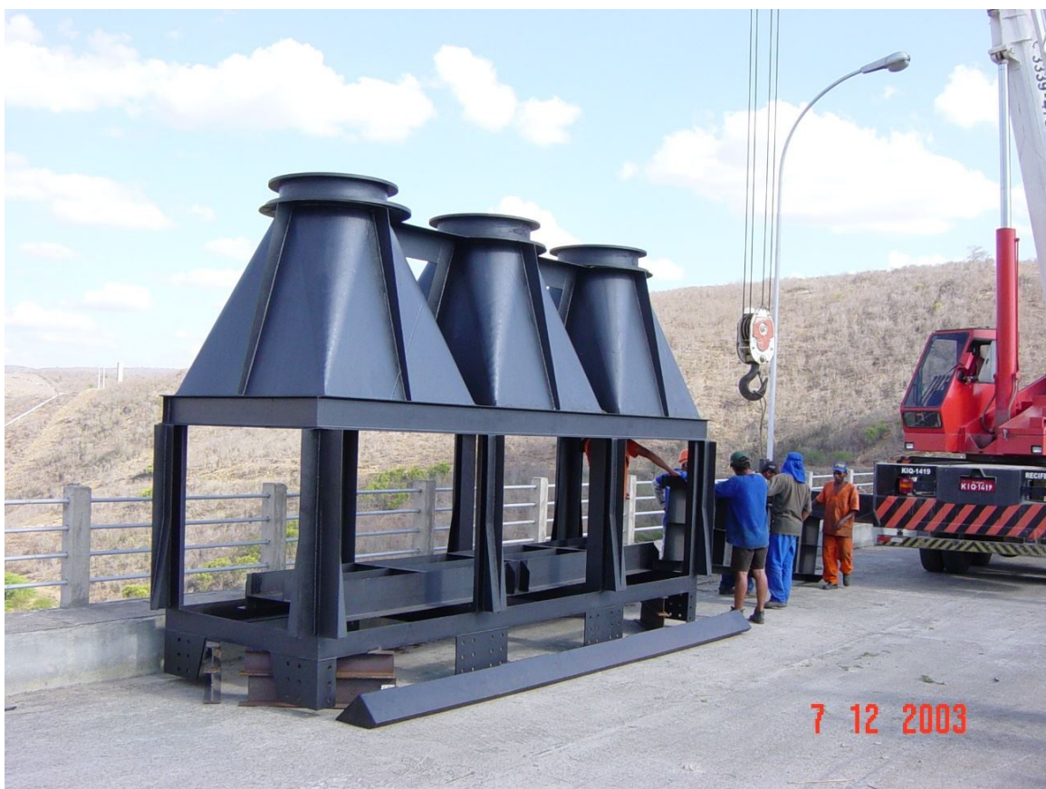
Figura 4 – Parte da estrutura do flutuante do açude Jucazinho com 3 orifícios para conexão dos tubos que conduzem a água de captação para a tomada d'água
