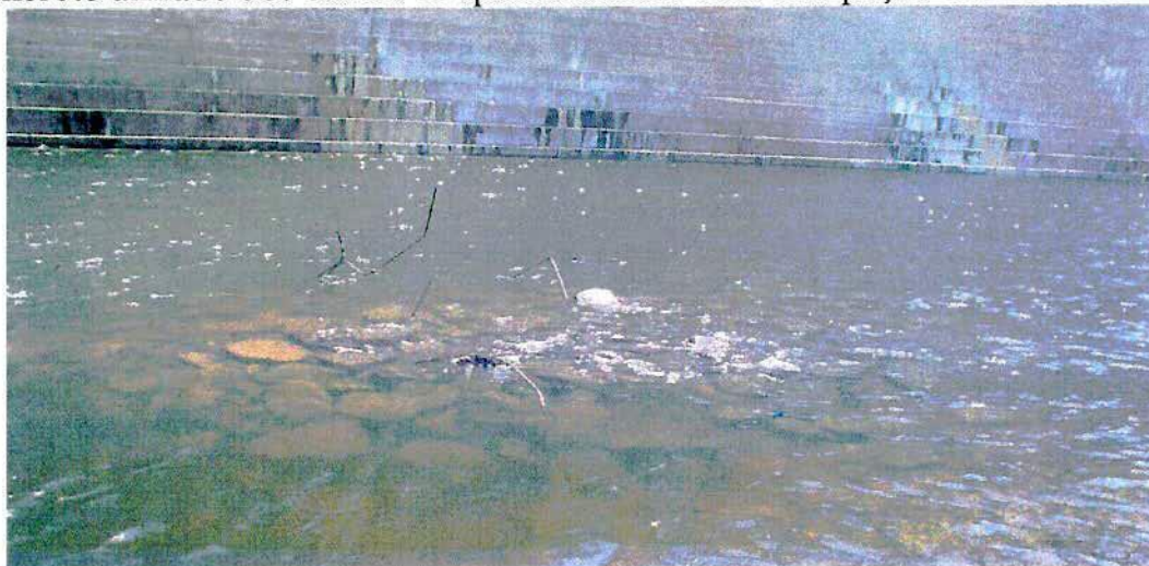
Bacia amortecedora com laje quebrada e ferragens retorcidas
