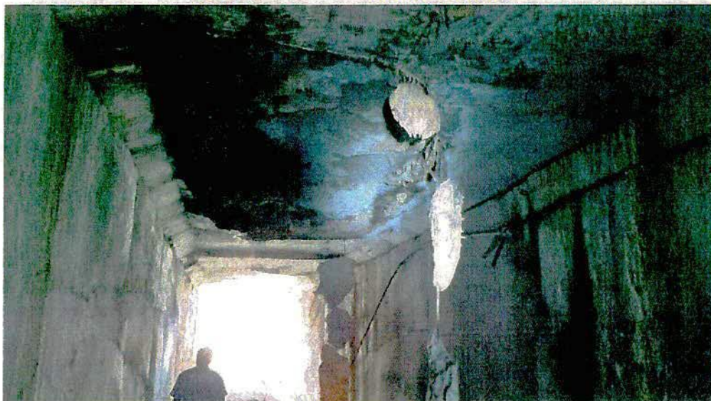
Figura 7 – Laje de teto, próximo à saída da galeria, suspensa pela ferragem (20/04/16).
