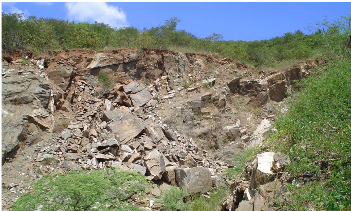
escorregamento de material obstruindo o canal do sangradouro de emergência direito
