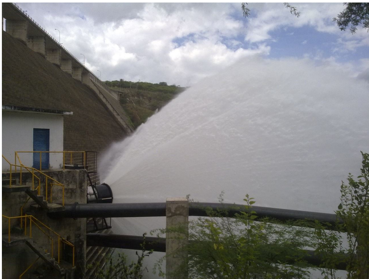
Figura 1 – Válvula difusora do açude Jucazinho em operação
