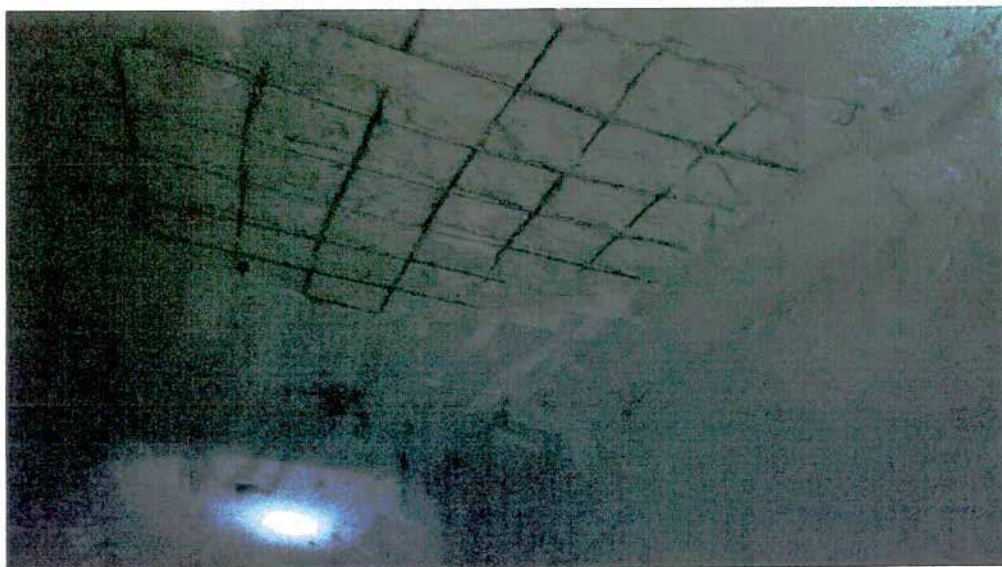
Figura 6 – Laje de teto com ferragem exposta (20/04/16).
