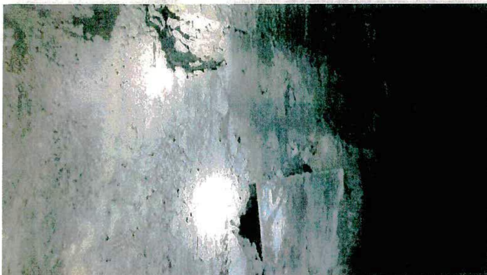
Figura 13 – Buraco formado por infiltração na parede de montante da galeria (20/04/16).
