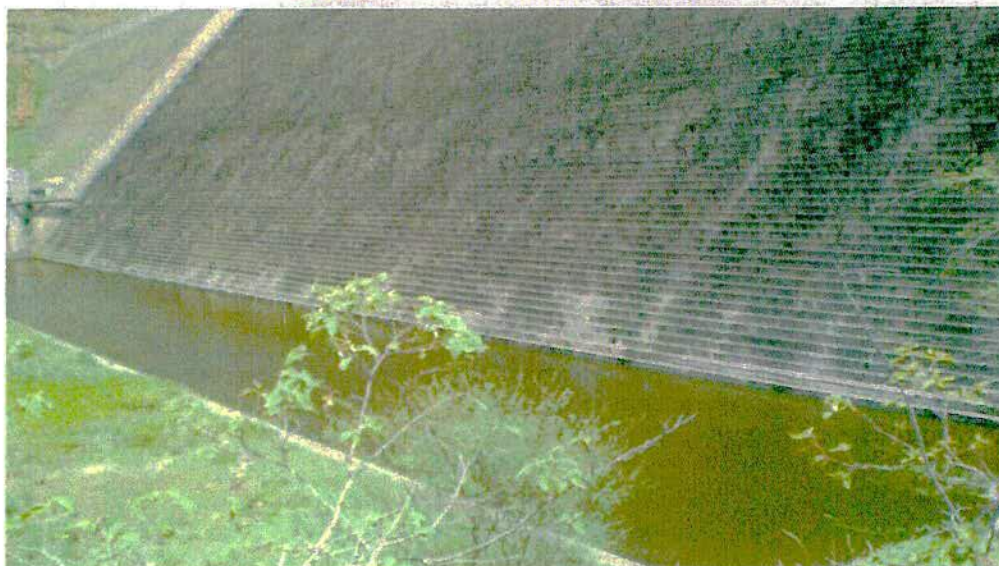
Figura 3 – Massa esbranquiçada no paramento de jusante sugerindo possível infiltração (20/04/16).
