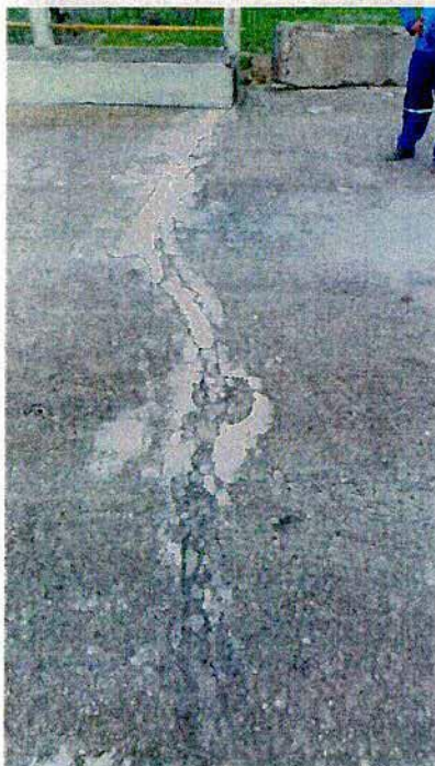
Figura 19 – Continuação da fissura na crista da barragem (20/04/16).
