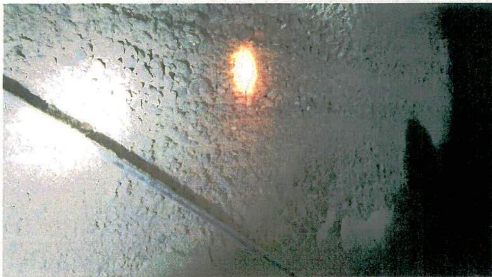
Figura 9 – Agregado do CCR exposto na lateral da galeria (20/04/16).
