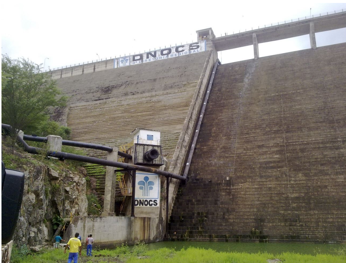
Figura 2 – Vista de jusante da barragem Jucazinho – válvula difusora – saída de água do sifão
