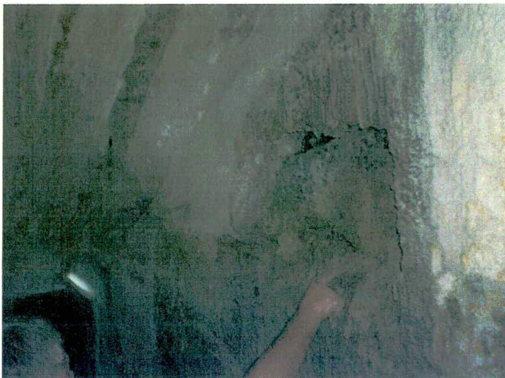
Figura 10 – Buraco formado por infiltração na parede de montante da galeria (20/04/16).
