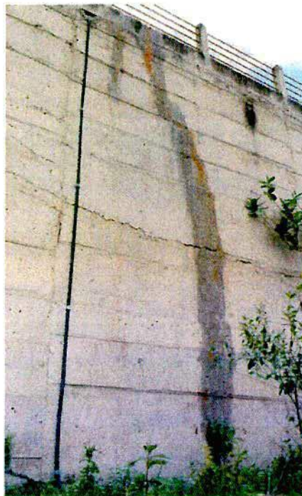
Figura 20 – Continuação da fissura em montante sugerindo um possível reparo realizado anteriormente (20/04/16).
