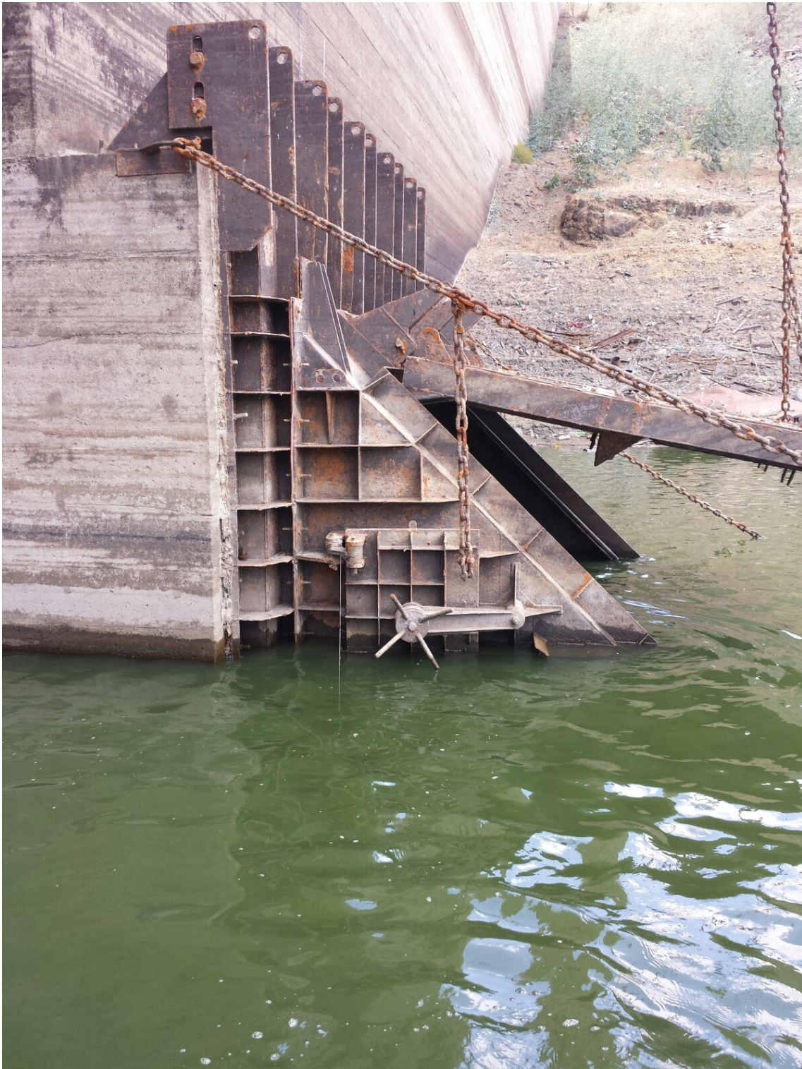
Figura 7 – Detalhe da estrutura da tomada d'água do açude Jucazinho
