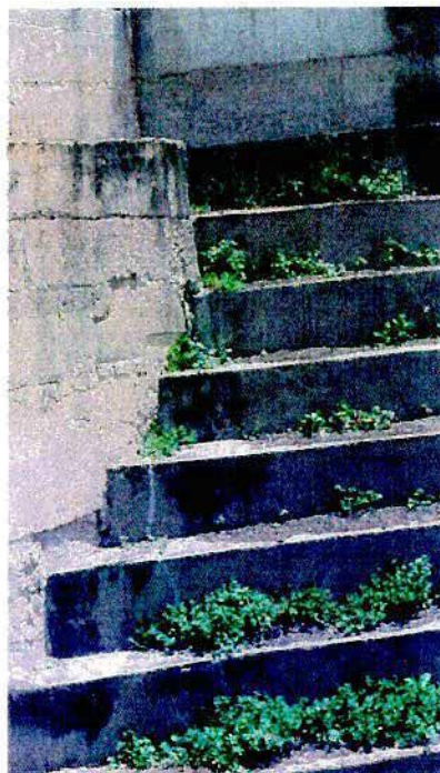
Figura 18 – Vista dos degraus a jusante com fissura acompanhando que transpassa pela crista da barragem até o paramento de montante (20/04/16).
