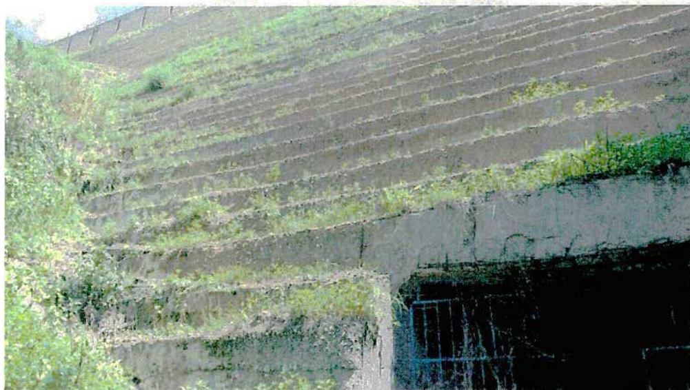
Figura 15 – Presença de vegetação nos degraus do paramento de jusante (20/04/16).
